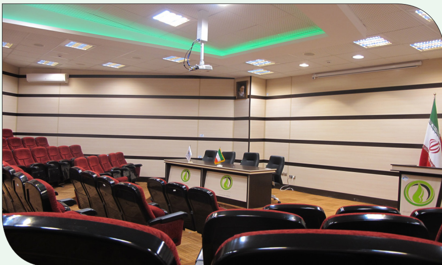
اجرای فضای داخلی و سیستم روشنایی سالن آمفی تئاتر دانشکده مهندسی زراعی
