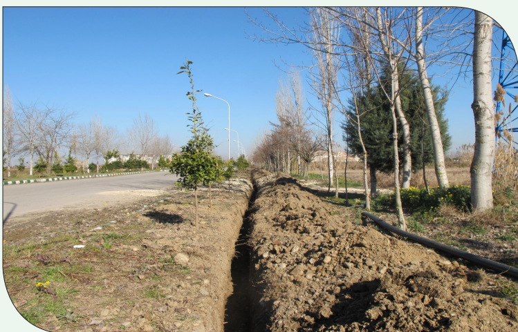
اجرای لوله کشی آب شرب دانشگاه
