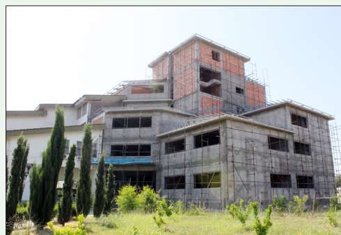
احداث و تجهیز مجموعه کلاس‌ها ( فاز ۲ علوم پایه )
