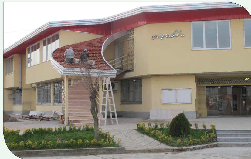
اجرای طبقه دوم ساختمان دانشکده مهندسی زراعی
